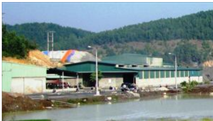
Nhà máy khai thác xỉ than của Công ty
