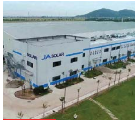
Dự Án Sản Xuất Cell, Công Ty TNHH Ja Solar, Bắc Giang
