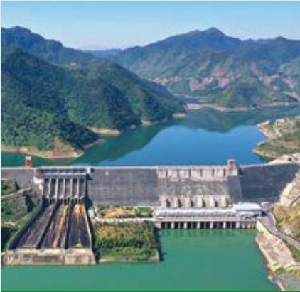
Công trình Thủy điện Sơn La
