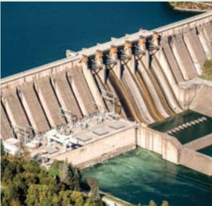
Công trình Thủy điện Xekaman - Lào
