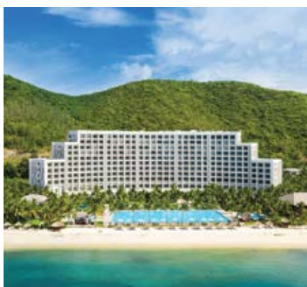
Dự án Vinpearl Island Condotel Hòn Tre
