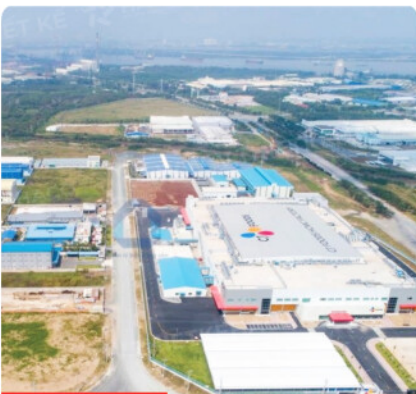
Xây Dựng Nhà Xưởng Tại KCN Việt Hàn, Việt Yên, Bắc Giang
