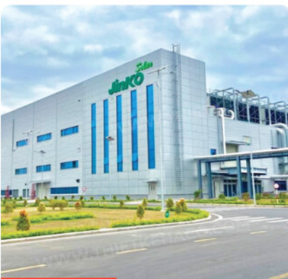
Nhà máy Jinko Solar Quảng Ninh
