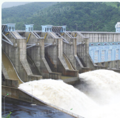
Công trình Thủy điện Xepian-Xenamnoy
