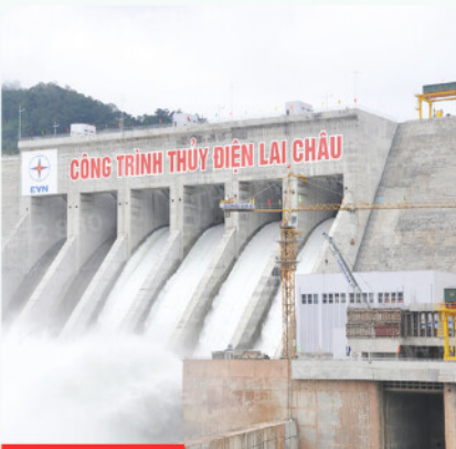
Công trình Thủy điện Lai Châu
