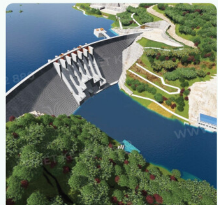
Công trình Thủy điện Nam Theun 1
